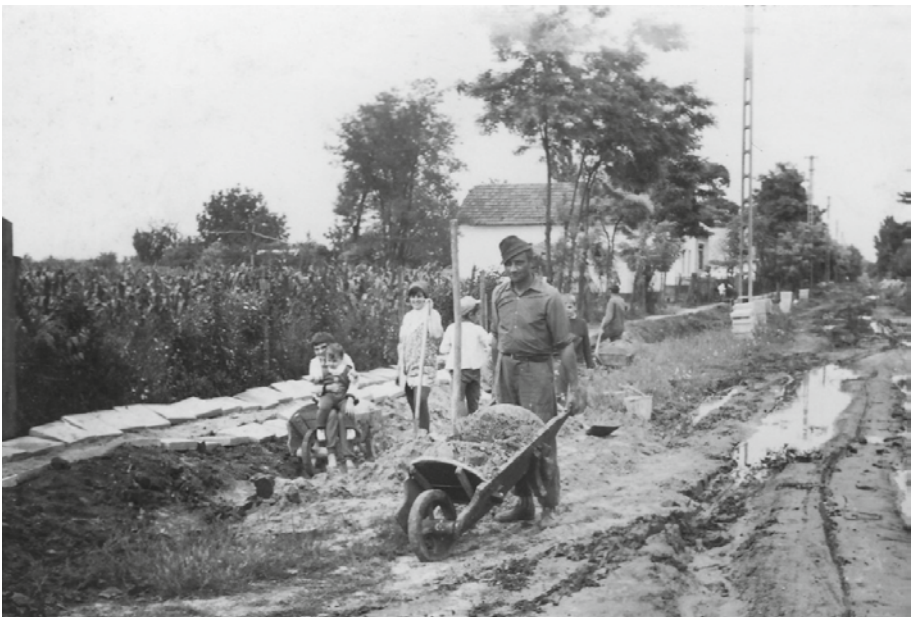
Épül a járda
