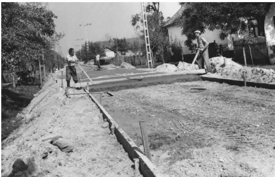
1985. Gyapjas Pál, ma Nagyatádi utca betonozása
